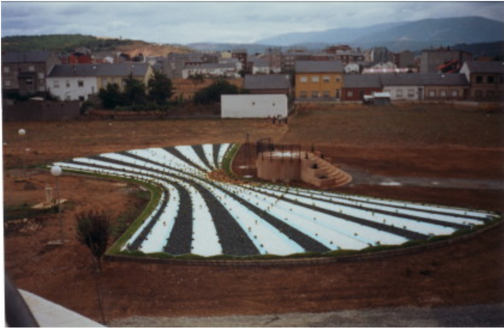
Foto.-2. Vista general del parque solar didáctico de Bembibre. Es evidente la forma de doble hacha
