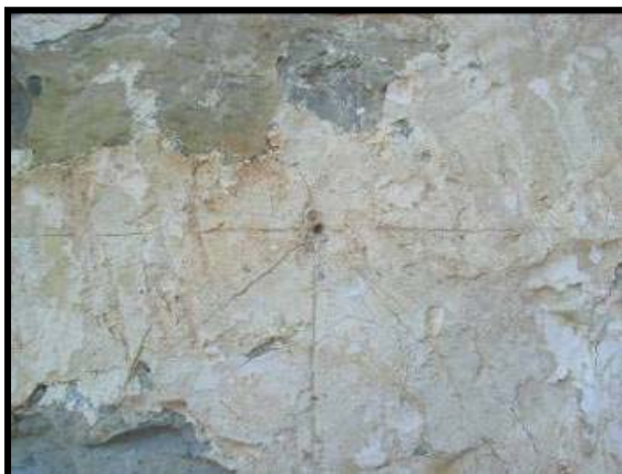
Betolaza. Reloj de 4x45° grabado en la argamasa.
