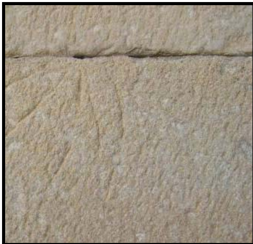
Reloj 1. Radial en junta de sillar.
