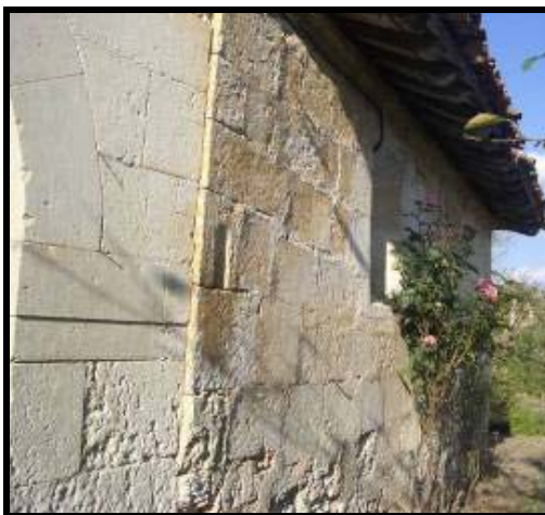
S. Pedro de Aguillo. Costado sur de la sacristía
