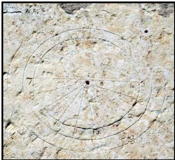
Situado en la ventana tapiada sobre la puerta.
