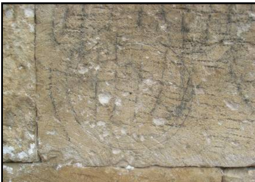
Circular en el centro del sillar.
