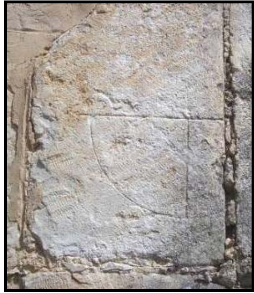
Traza semicircular cortada al construir el pórtico.
