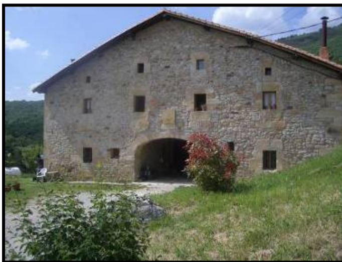
Caserío Marutegi. Fachada principal orientada al mediodía.
