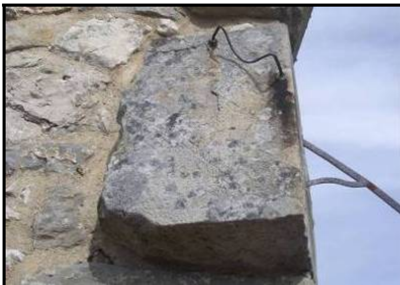
Reloj 2. VP. Varilla original doblada. M. Urteaga.
