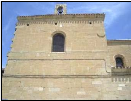
Zambrana. El reloj en el muro del crucero.
