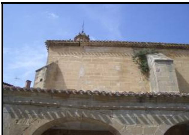
Situación del reloj de sol en el centro del muro.
