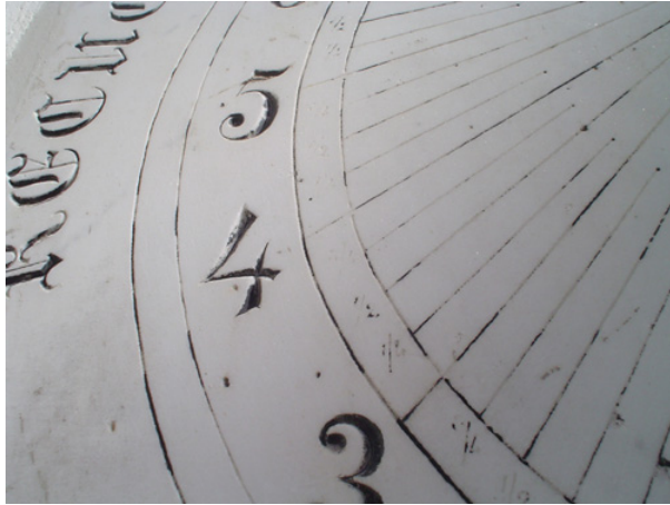
Números exquisitamente tallados pero con la pintura deteriorada muestran la urgente necesidad de restauración
