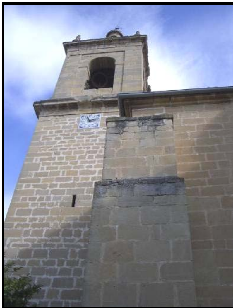
Nª Sª el Rosario. Contrafuerte de la esquina suroeste
