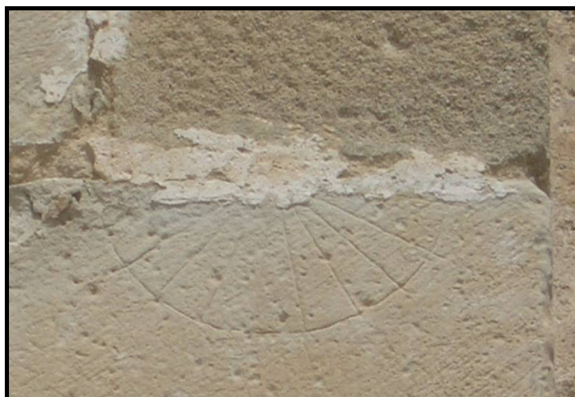
Reloj semicircular de 10x18°. Línea de Mediodía desviada
