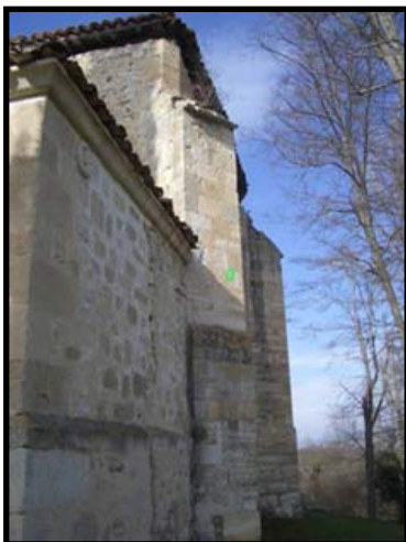
Torre. Contrafuerte Sureste
