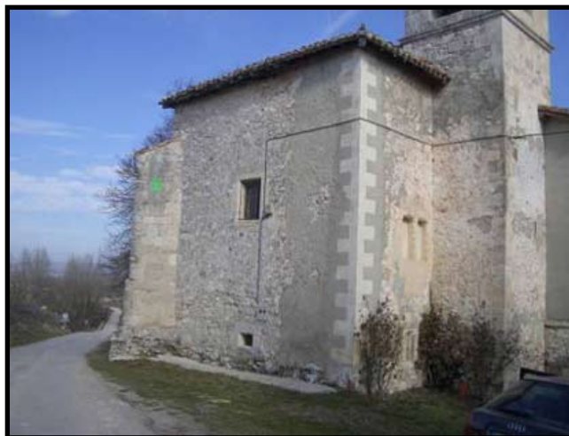
Contrafuerte de la esquina Noroeste
