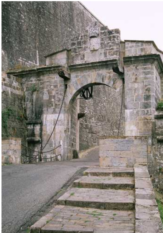
Portal de Francia o de Zumalacárregui (1751-1759), con su Puente levadizo proyectado por varios ingenieros. Diseñado definitivamente por Verboom en 1726.
