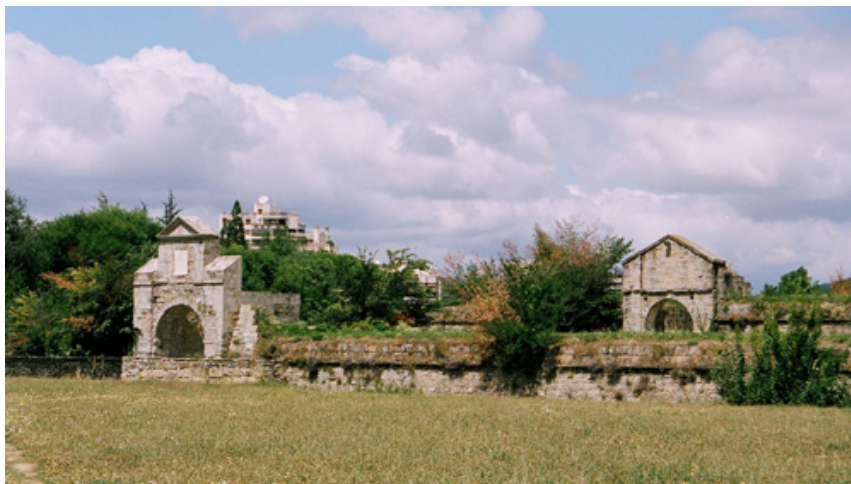
Contraguadías previas al acceso a la Ciudadela por la Puerta del Socorro.
