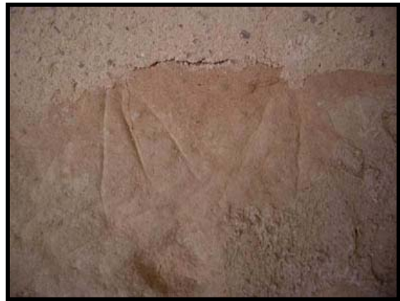
Relojes 1 y 2. Radiales en junta de sillar.
