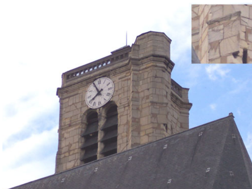
Foto 5. Torre de la Iglesia de Saint-Gervais-Saint-Protais y detalle del reloj de sol testigo
