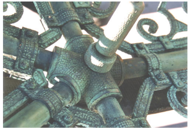
Detalle anclaje inferior del gnomon
