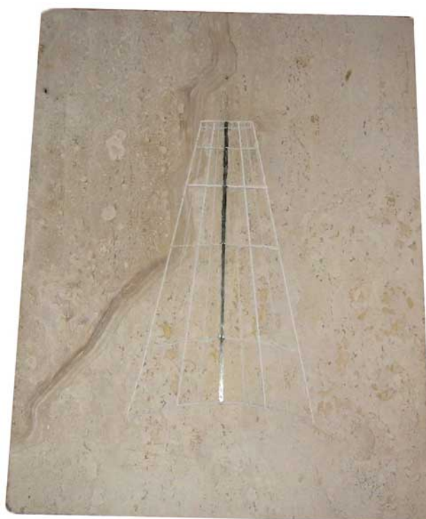
Meridiana repasada con la cuchilla para igualar las superficies.
