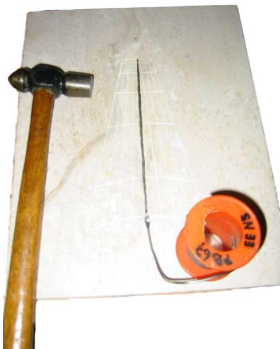
Hilo de soldar ya empotrado en la fisura.
