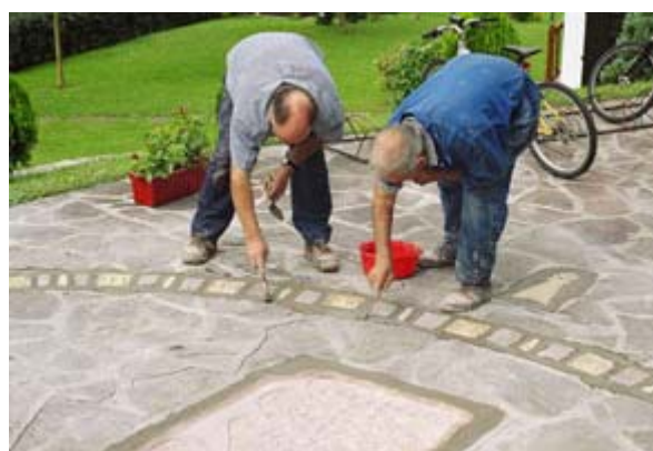
Rejuntando las losetas de las horas.
