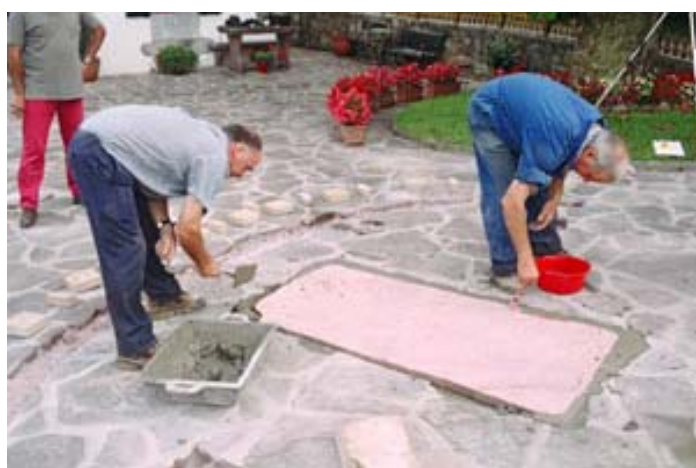
Rejuntando la losa de los meses.
