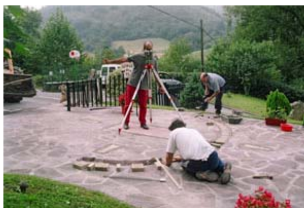
Colocación de las losetas de las horas.
