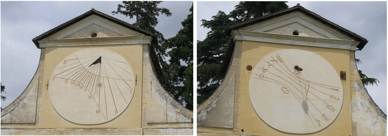
Foto 10,11 – A sinistra l'orologio con stilo a vela, ore di tempo vero e curve di declinazione solstiziali, a destra lo gnomone a disco forato per il calendario zodiacale. Sundial Atlas IT5756 e IT5755 .
