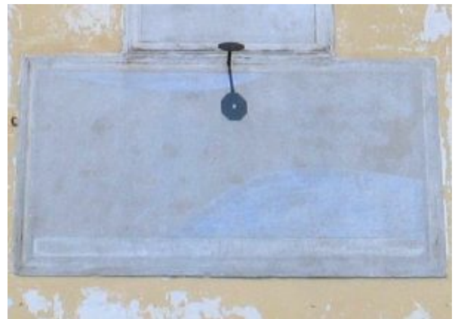
Figg. 3, 4 - Orologio datato 1875 segna l'ora vera locale e riporta le curve di declinazione relative ai Segni. Il quadrante sovrastante mostra la curva del mezzogiorno medio e le linee che segnalano intervalli di 5 minuti prima e dopo il mezzodì vero. Il motto suggerisce che "È L'ORA DI FARE IL BENE", altre scritte riportano le coordinate del luogo, la data, il nome del costruttore (probabilmente inserito dal restauratore a "memoria" assieme alle sue iniziali) accanto alla data del restauro. Sopra, lo stato della meridiana prima del restauro tratta da SA dove l'orologio è censito con il numero IT8646
