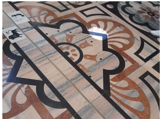
La macchia di luce sul pavimento del Duomo.
