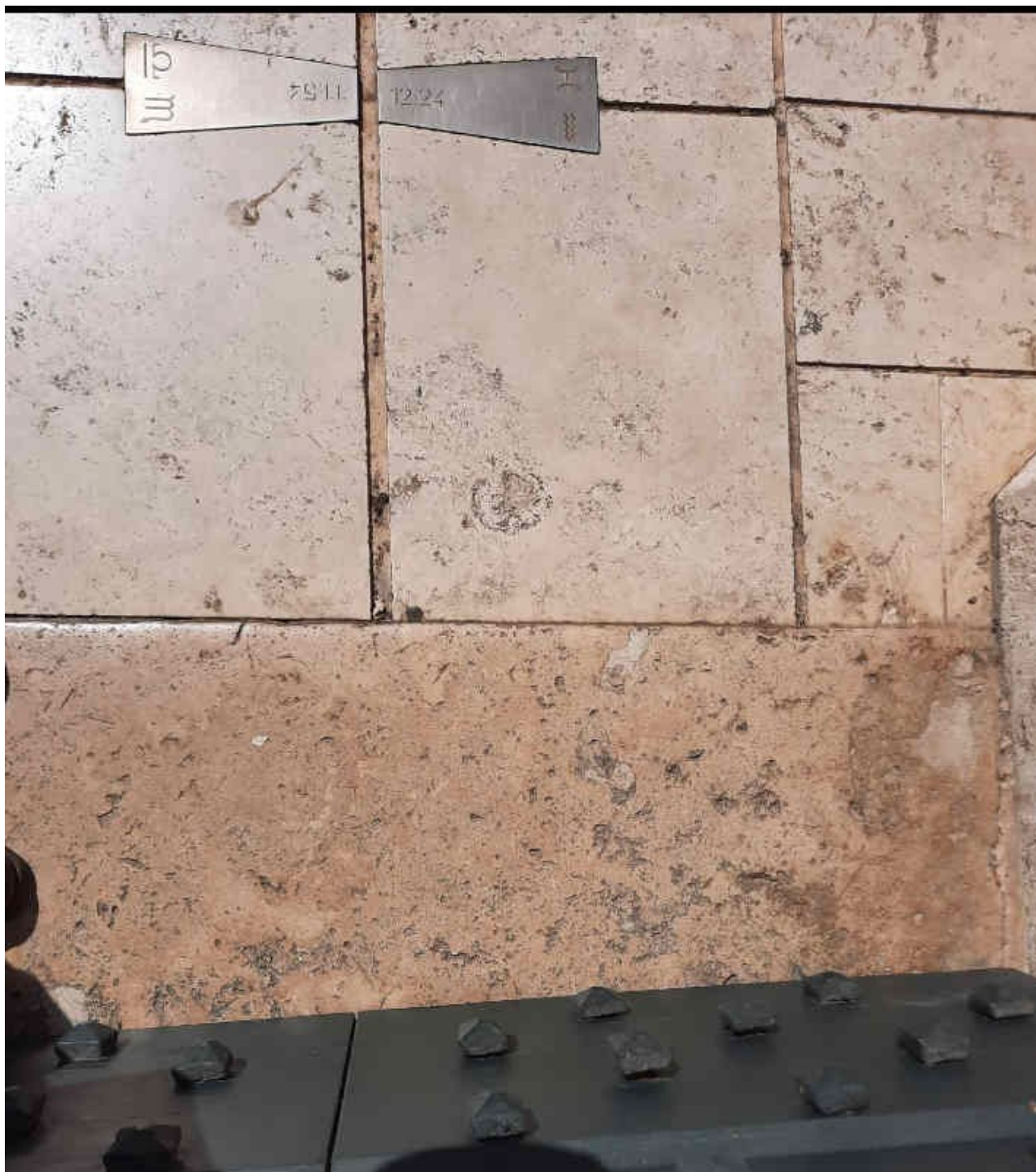
Fig. 4 – Nella foto l'estremità settentrionale della LM: a dx il trapezio di titanio che separa il segno di Aquario (che non c'è) da Pesci (declinazione in ascendenza), transito alle 12:24 TMEC; a sx il trapezio che indica il passaggio da Bilancia a Scorpione (che non c'è) per declinazione in discendenza e il TMEC (11:54). Nella foto si riconosce l'estremità inferiore del portone d'ingresso del Palazzo. La fotografia è di Cesare Lucarini.
