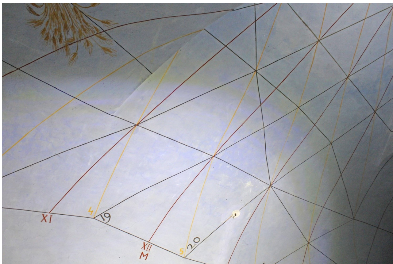
Fig. 14 – Il tracciato orario intorno alla Linea Meridiana (XII-M), con le Ore Italiane in nero e numeri arabi, le Babiloniche in Giallo ambra e numeri arabi, e le Astronomiche in rosso e numeri romani.
