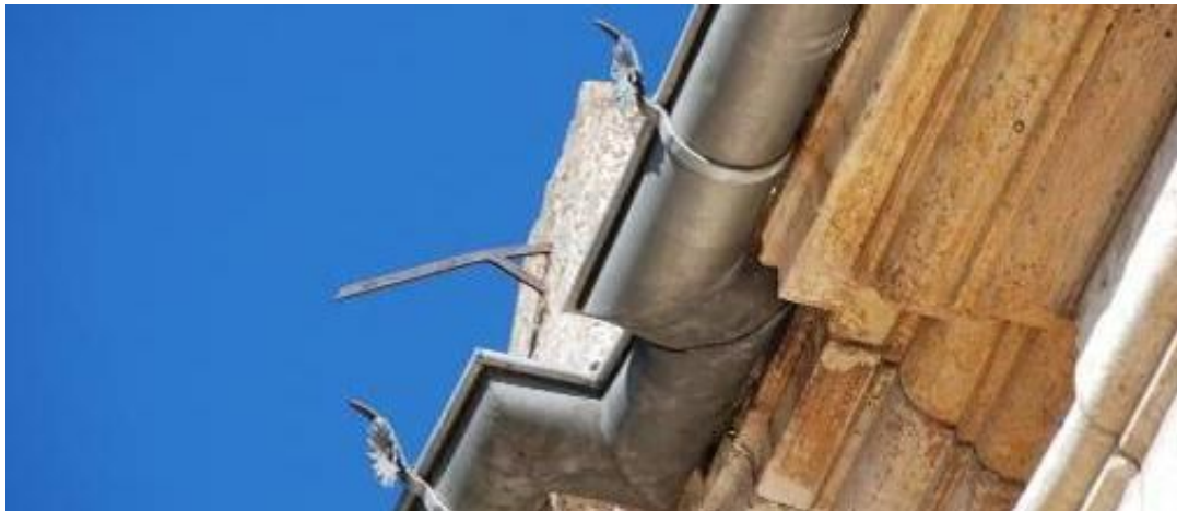
Varilla de hierro de perfil plano, de dos apoyos en “y”.
