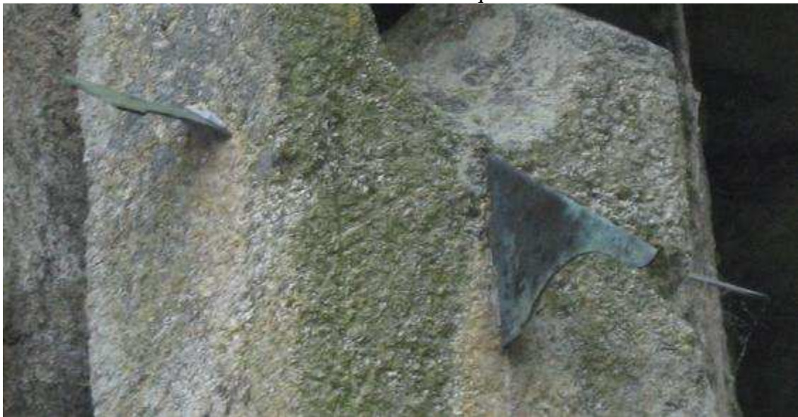
Detalle: gnómones de los tres cuadrantes verticales recortados en chapa de bronce.
