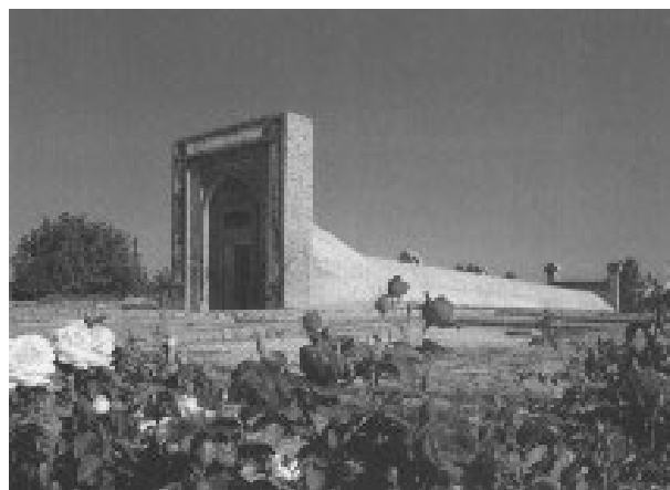
fig. 3 SAMARCANDA - L'esterno della costruzione contenente il grande quadrante
