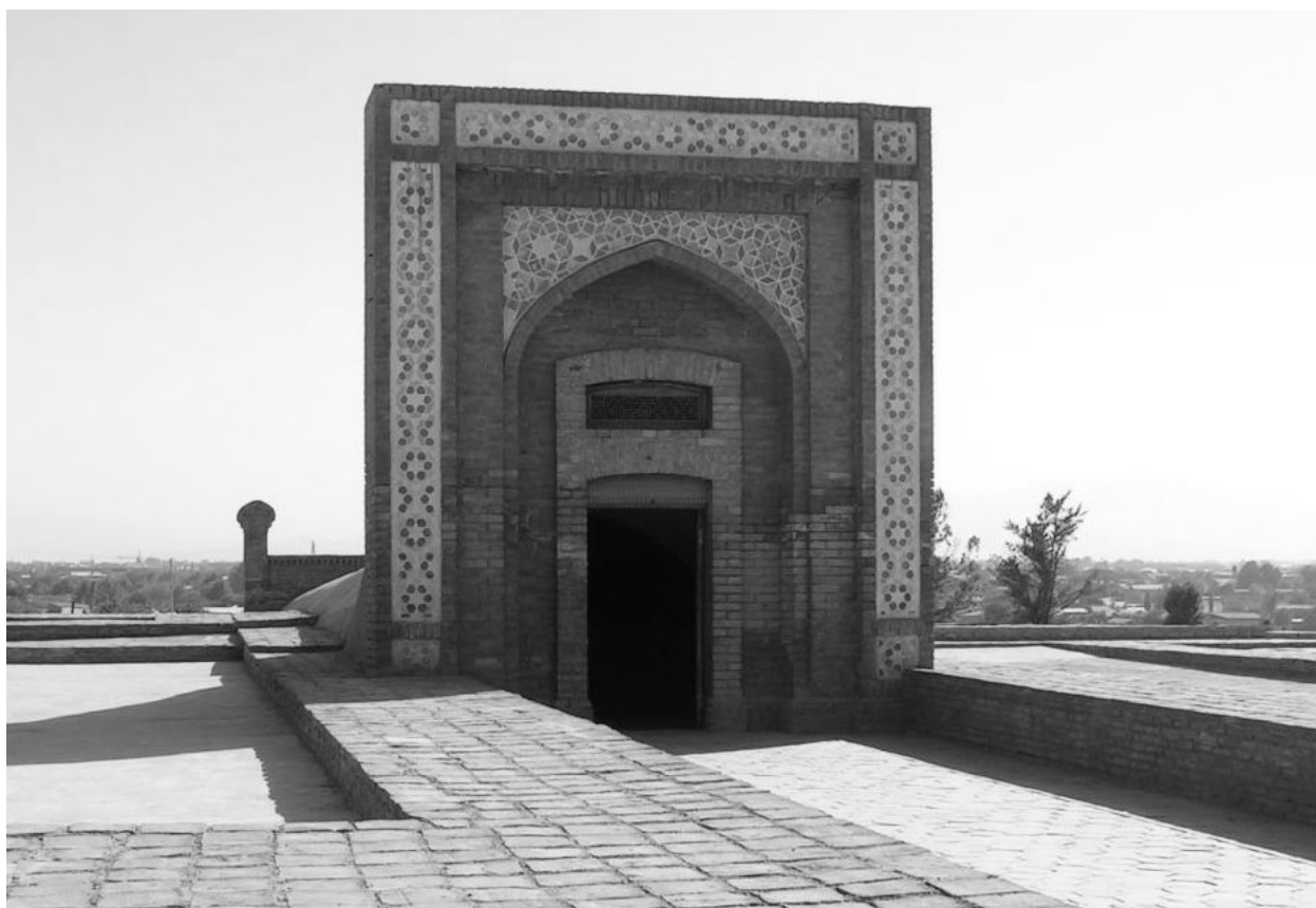
fig 5 SAMARCANDA - Il fronte della costruzione contenente il grande quadrante
